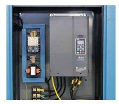
Снижение минимальной рабочей частоты двигателя до 25 Гц при помощи частотного преобразователя (расширение I в названии модели) позволяет понизить нижний уровень производительности компрессора на 40%, и, тем самым увеличить диапазон его применения.
